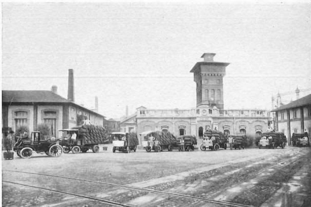
Autoveicoli elettrici azionati da accumulatori *Tudor*, della Impresa Trasporti Elettrici Caliari di Torino, adibiti al trasporto del carbone per conto della Soc. An. Italgas.
