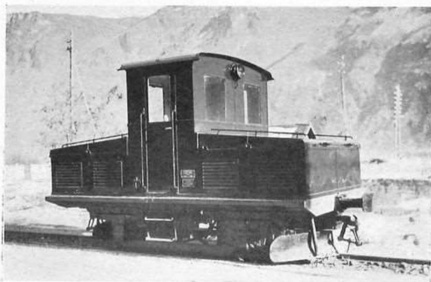
Locomotore elettrico di manovra azionato da accumulatori *Tudor*, in servizio presso la Ferrovia Elettrica Val di Fiemme.
