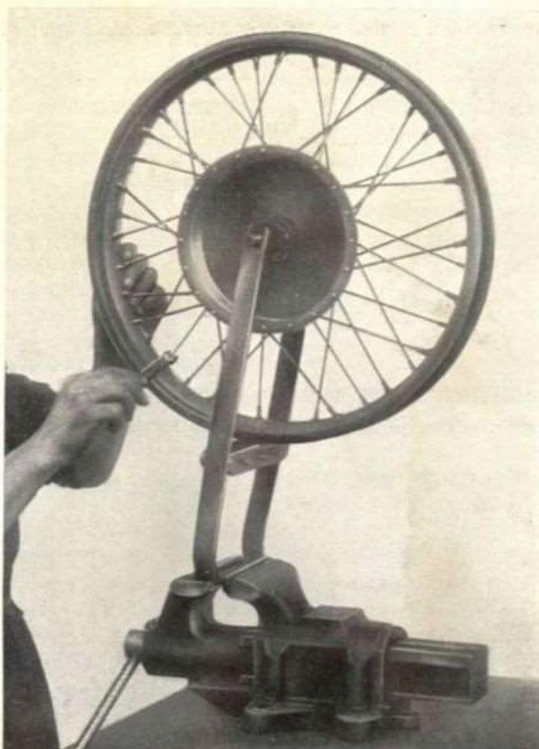
Fig. 140 -- **A 46** Apparecchio e chiave per centrature ruote
